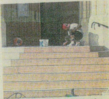
Les marches de l'église ont été rénovées.
