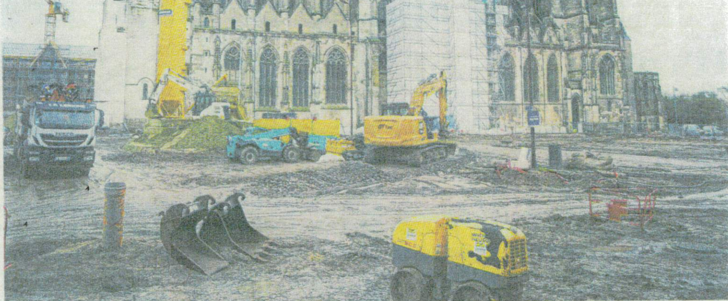
Alors que les travaux de comblement des souterrains sont presque terminés, un travail de terrassement et d'assainissement est en cours. Gaël Héroux
