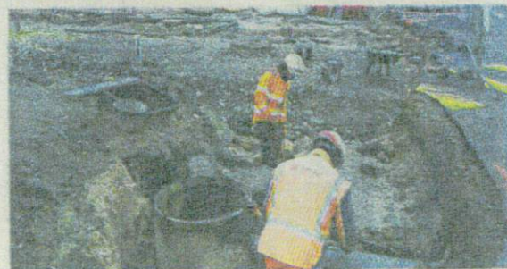
Alors que les travaux de comblement des souterrains sont presque terminés, un travail de terrassement et d'assainissement est en cours. Gaël Héroux
