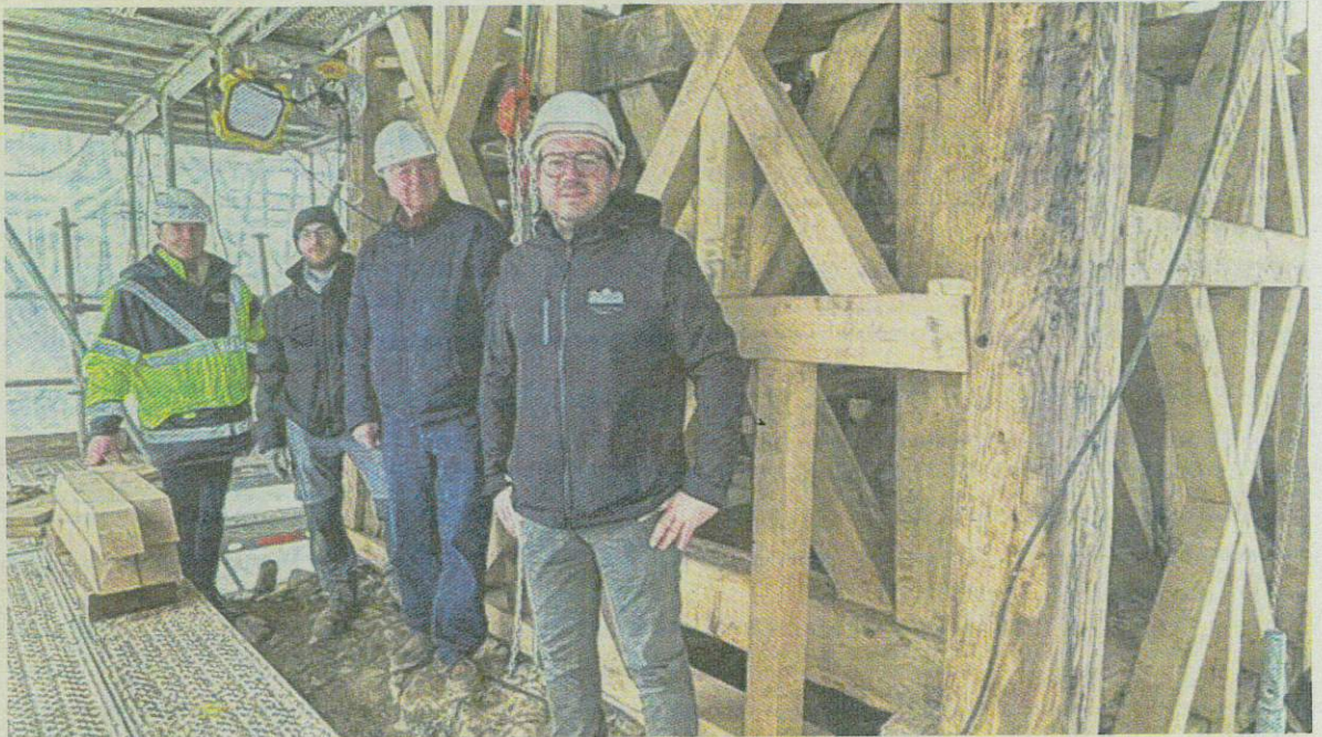
Tous les quinze jours, l'ensemble des parties pronantes du chantier se réunit afin de faire le point sur l'avancée des travaux. Chloé Gaillard
