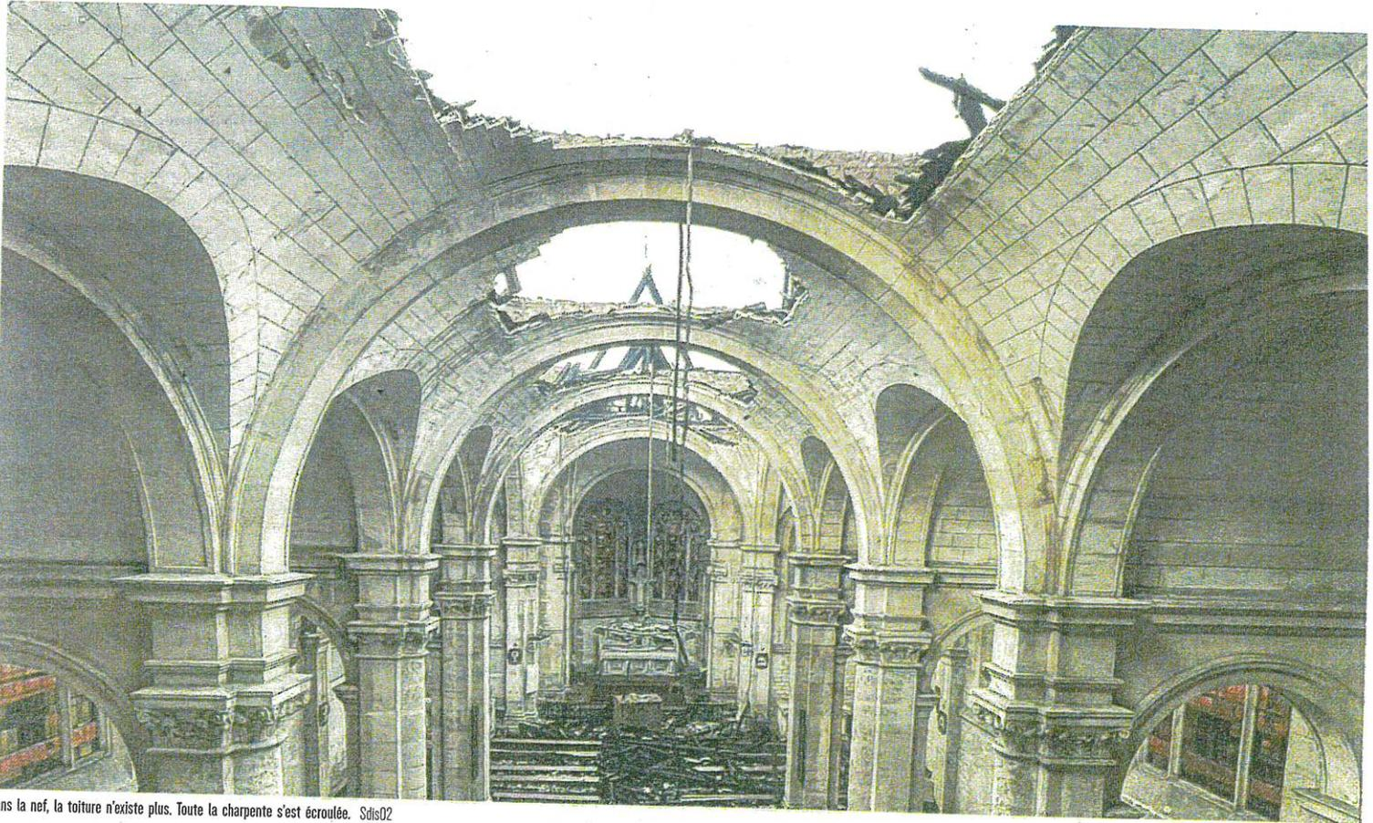
Dans la nef, la toiture n'existe plus. Toute la charpente s'est écroulée. Sdis02
